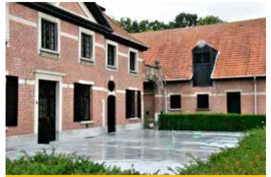
▲ De Hemelhoeve zal heropenen na grondige renovatiewerken binnen én buiten.
