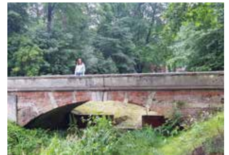
▲ De kasteelbrug wordt volledig opnieuw opgebouwd, met behoud van de historische elementen.
